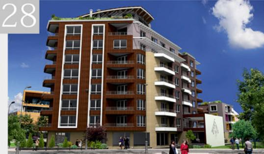
**Груб строеж:** Ж.К. "Тиара" е проектиран с монолитна скелетна стоманобетонна конструкция. Конструкцията е съобразена с нормативните изисквания за проектиране в сеизмични райони – IX степен по скалата на Медведев – Шпонхоер – Карник за София.
